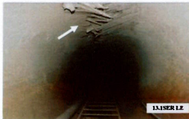
Figura 5 - Problemas de quebra mecânica – Breakout
